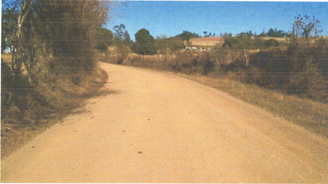
VISTA DA ÁREA - 5
